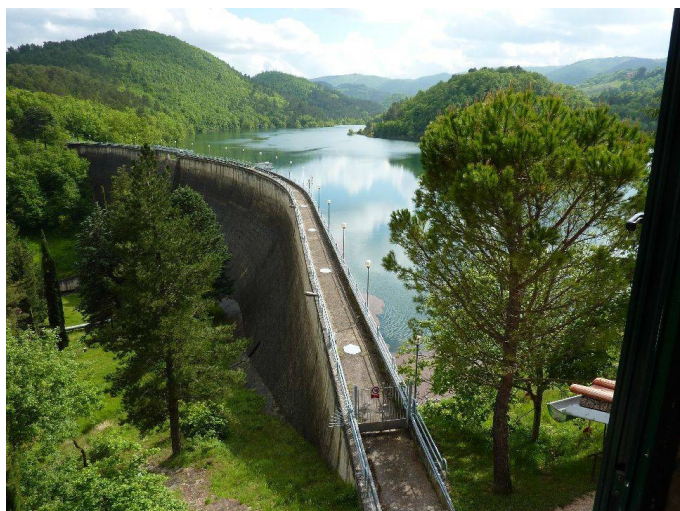
Diga di Arezzo sul torrente Marroggia (Spoleto)
