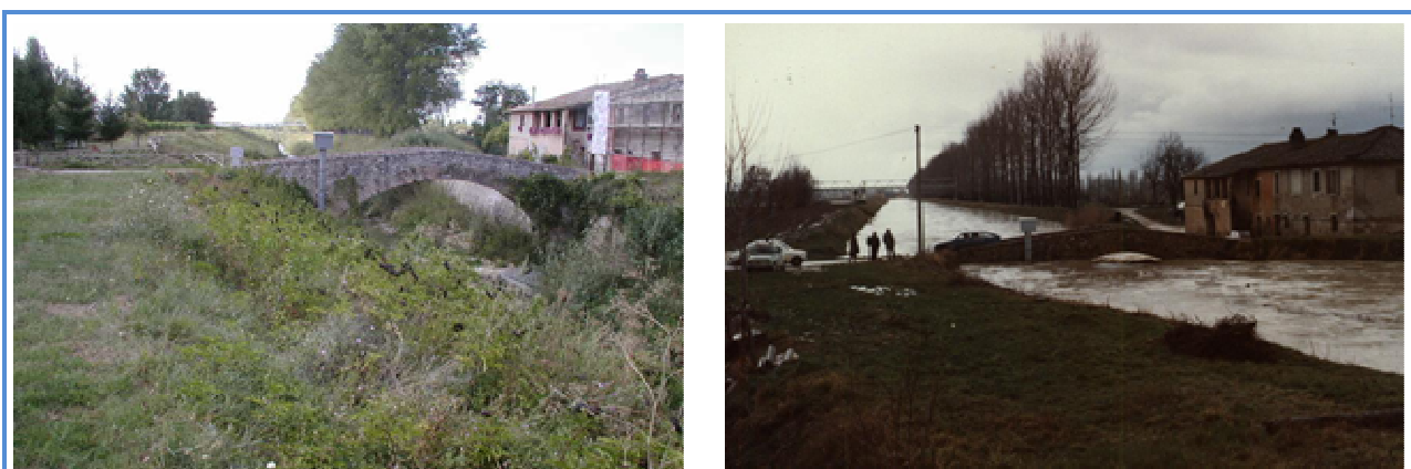
T. Tevere in loc. Torre di Montefalco in condizioni normali e in condizioni di piena (rigurgito dovuto presenza del ponte Ruscitolo, 25 e 26/02/1984).
